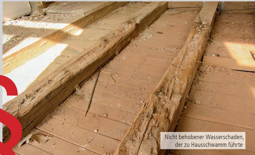
Nicht behobener Wasserschaden, der zu Hausschwamm führte
